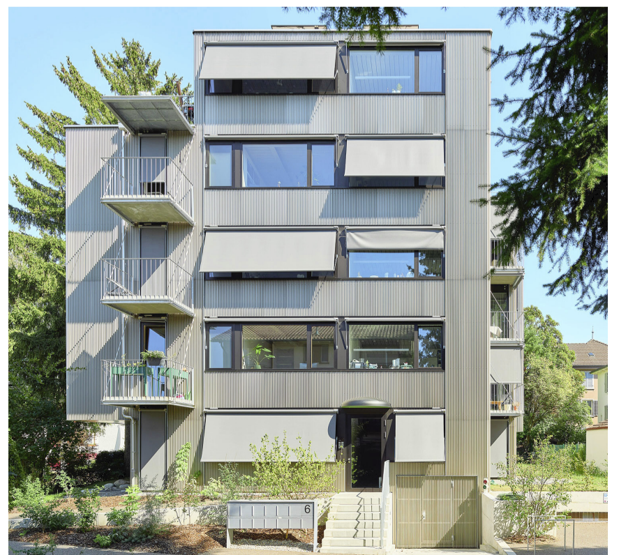
Das «Kreislaufwohnhaus» am Herbstweg in Zürich-Oerlikon. BILD PHILIP HECKHAUSEN
