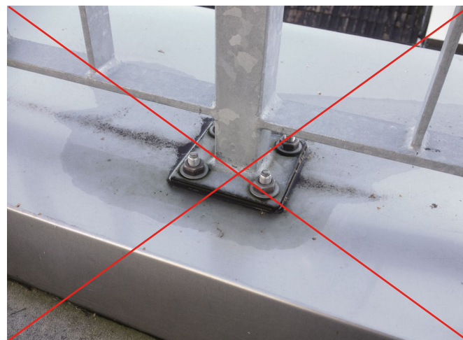
Fig. 7: Exécution défectueuse, inadmissible
